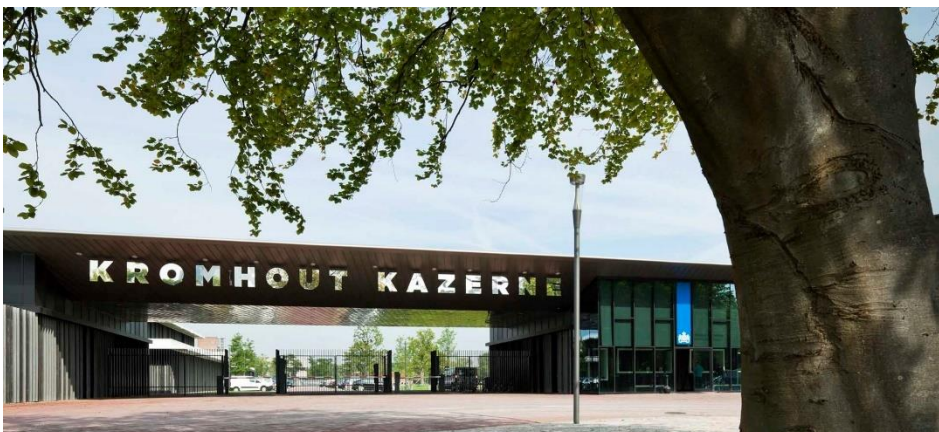
Figuur 10 De Kromhoutkazerne in Utrecht (Ballast Nedam, 2017)
